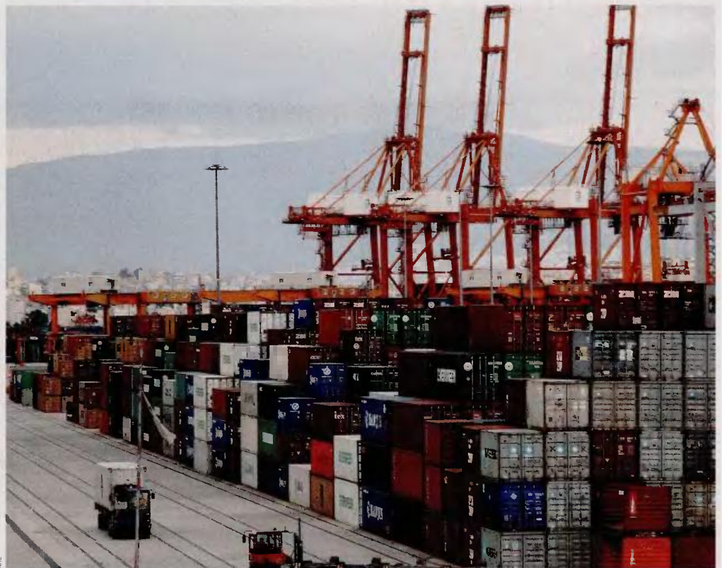
Ο Πειραιάς αναπτύσσεται ραγδαία. Από το 2009 και μετά, έχει αναρριχηθεί στην 8η θέση των μεγαλύτερων λιμανιών της Ευρώπης, ως ένας ισχυρότατος διαμετακομιστικός θαλάσσιος κόμβος της Μεσογείου.
