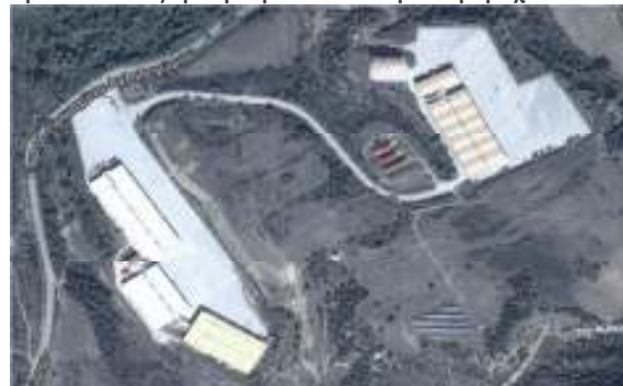
Σχήμα 5.11 Εγκαταστάσεις Εμπορευματικού Κέντρου Προμαχώνα
